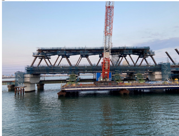
② 上部工架設工
