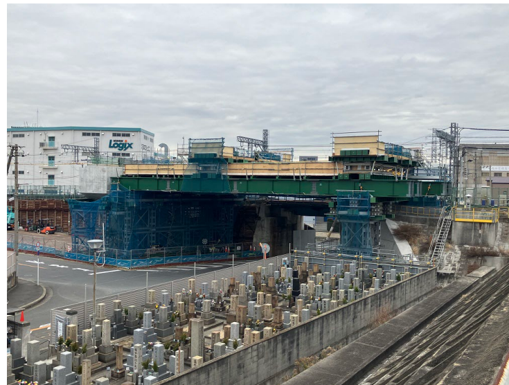
② 上部工架設準備工（工事桁架設）
