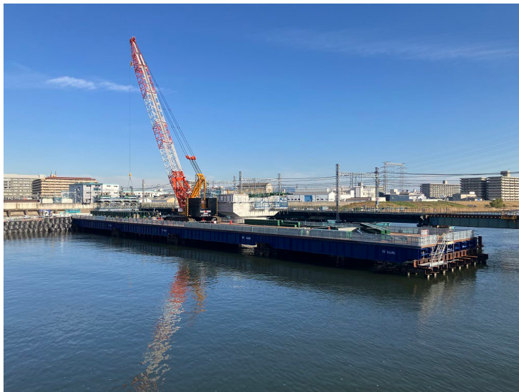
① 上部工架設準備工（仮栈橋設置）
