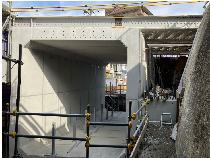
④ボックスカルバート翼壁構築工
