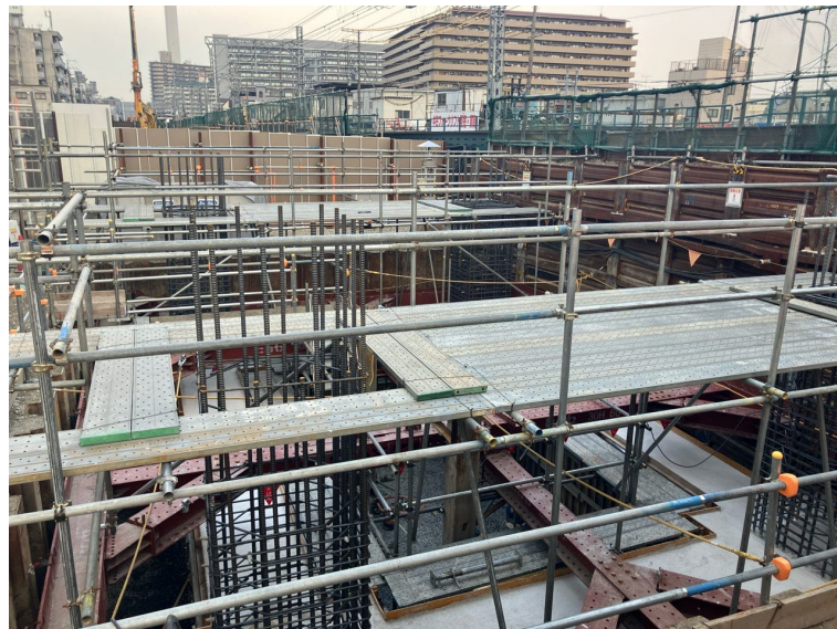
④躯体構築工（地中梁、柱）
