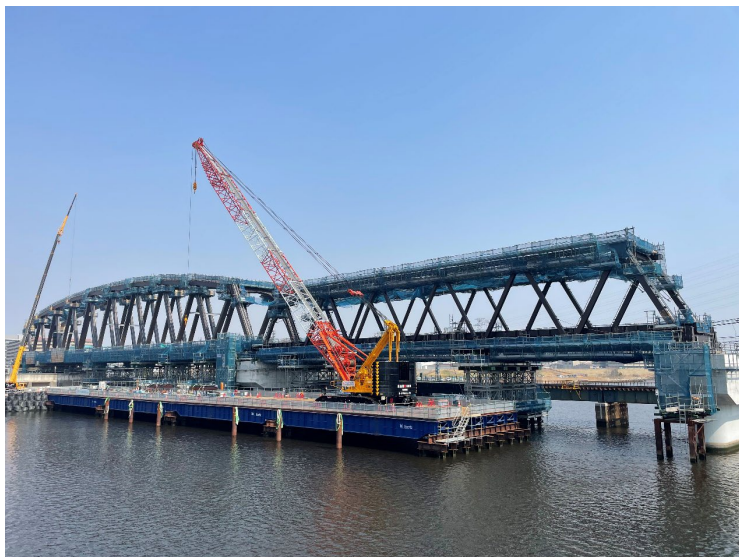
③ 上部工架設工（曲弦トラス桁：陸上部）
