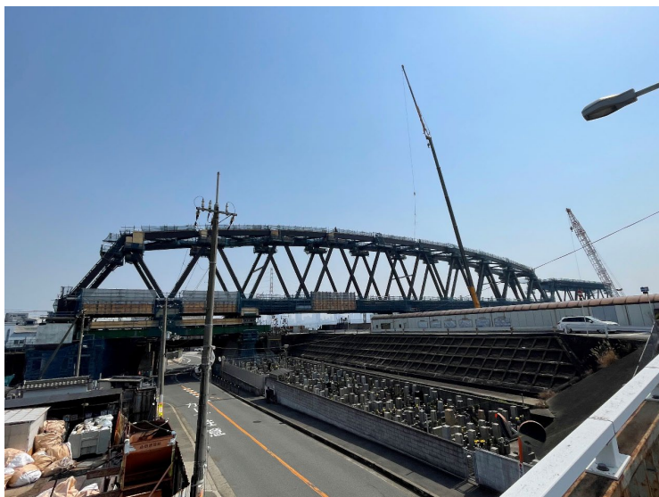
③ 上部工架設工（曲弦トラス桁：陸上部）
