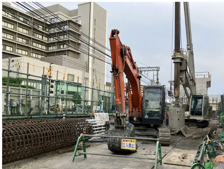
①場所打ち杭工
