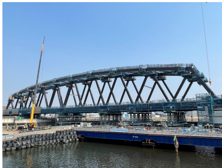
④ 上部架設工（曲弦トラス桁：河川部）
