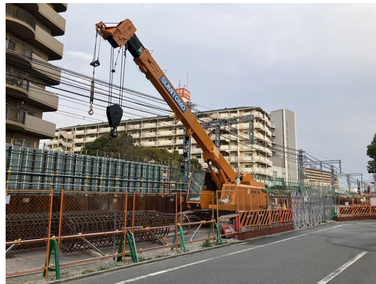
②場所打ち杭工
