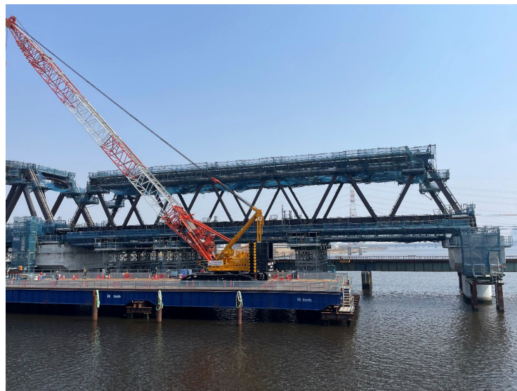
④ 上部架設工（曲弦トラス桁：河川部）
