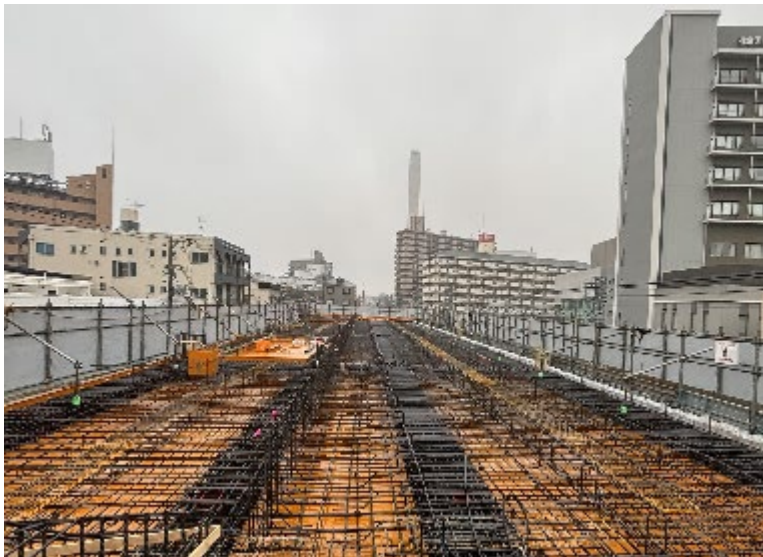
①躯体構築工（上床梁、スラブ構築）
