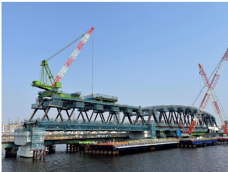
③上部工架設工（曲弦トラス桁：河川部）
