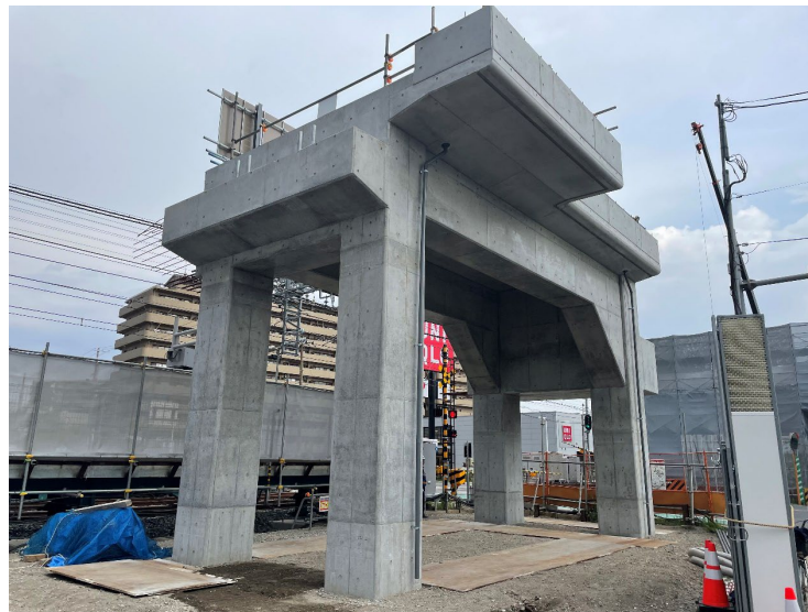
④躯体構築工（地中梁、柱）
