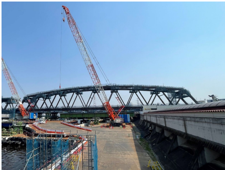
③上部工架設工（曲弦トラス桁：河川部）
