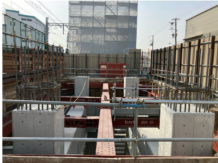
④躯体構築工（地中梁、柱）
