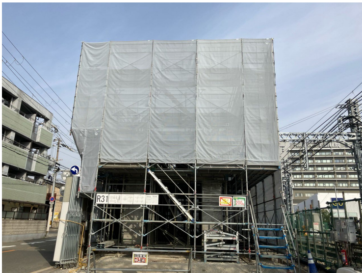
③躯体構築工（柱）
