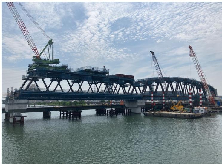
②上部工架設工（仮栈橋、斜路撤去）
