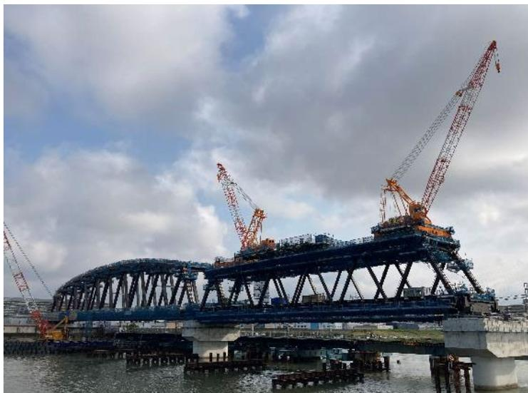
② 上部工架設工（仮栈橋撤去）
