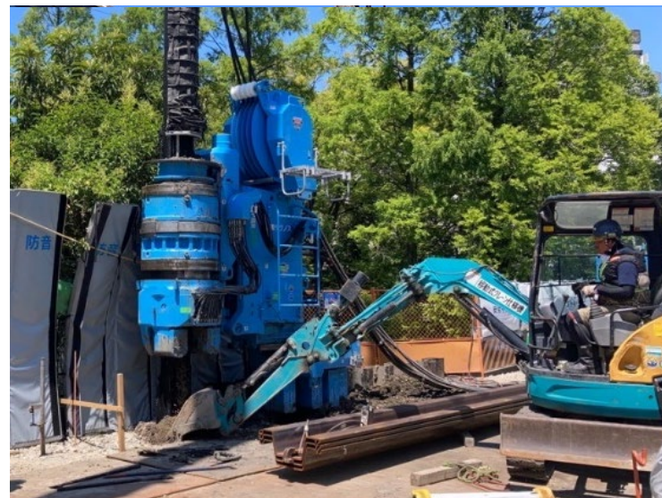
②鋼矢板圧入工
