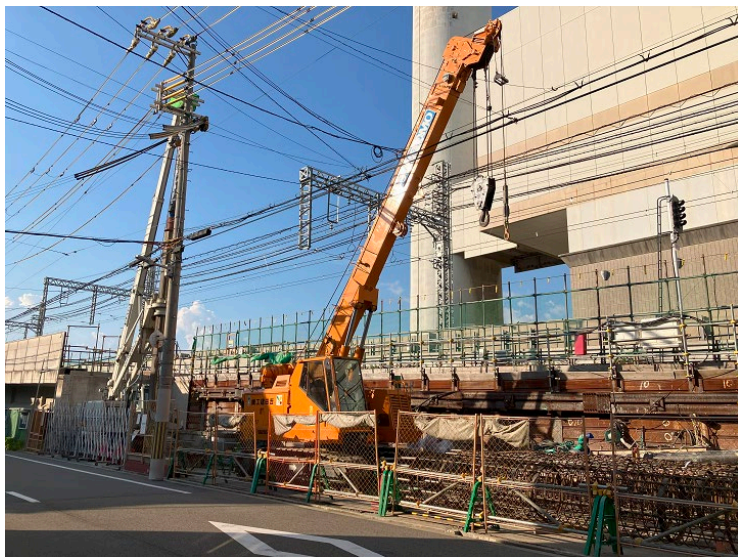
①場所打ち杭工
