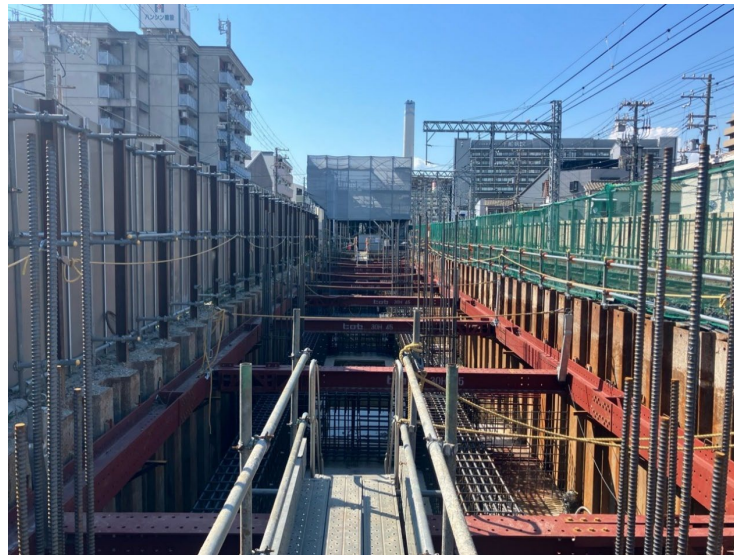
④躯体構築工（地中梁）
