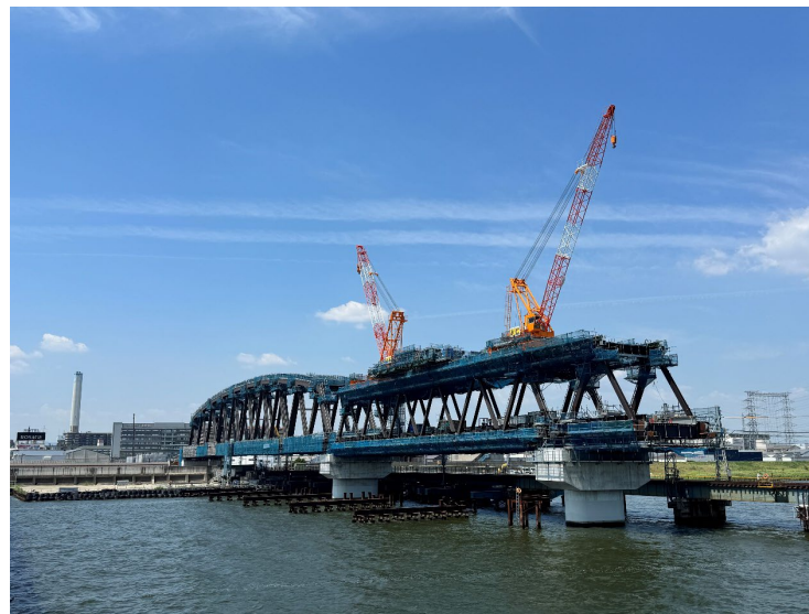
②上部工架設工（全景②）
