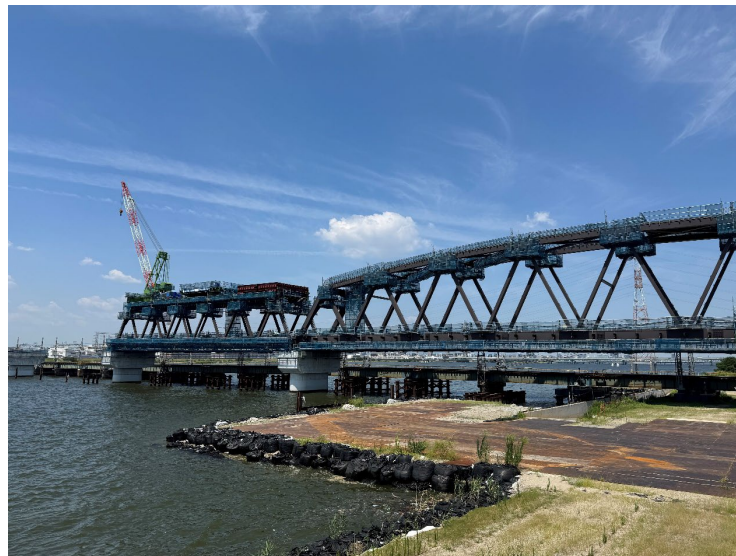
②上部工架設工（全景②）
