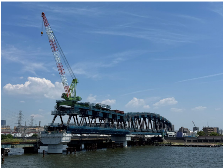
①上部工架設工（全景①）
