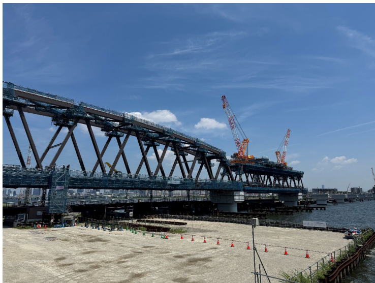
①上部工架設工（全景①）
