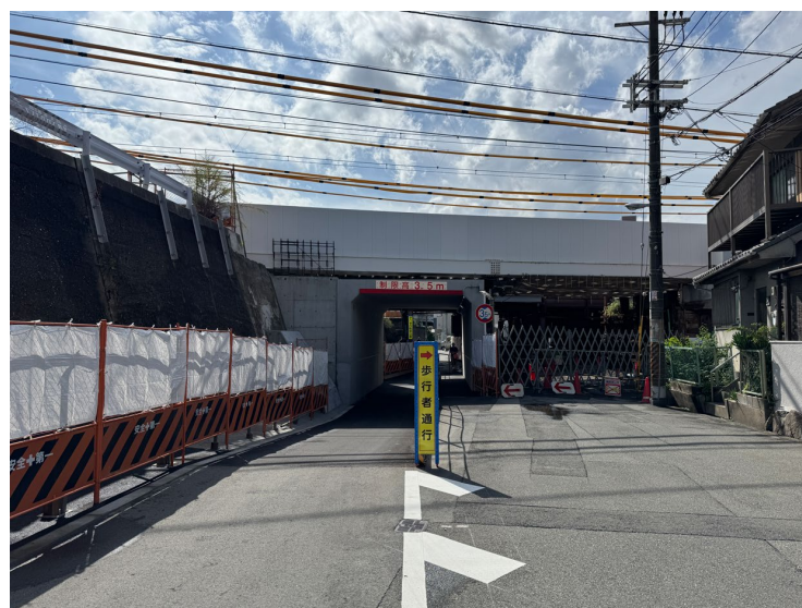
④ボックスカルバート工
