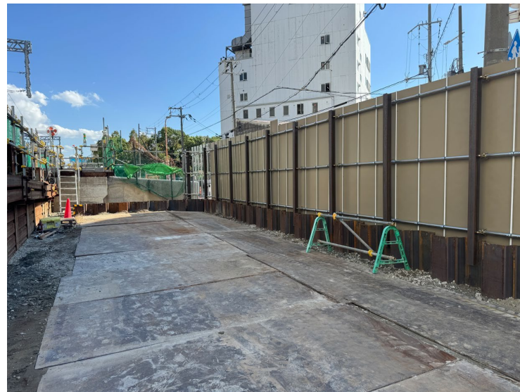
②鋼矢板圧入工
