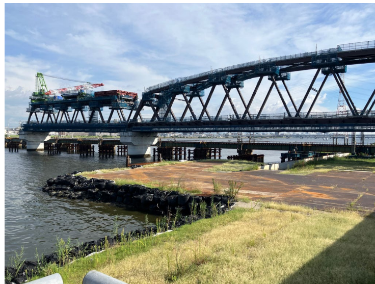
②上部工架設工
