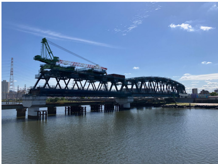
①上部工架設工
