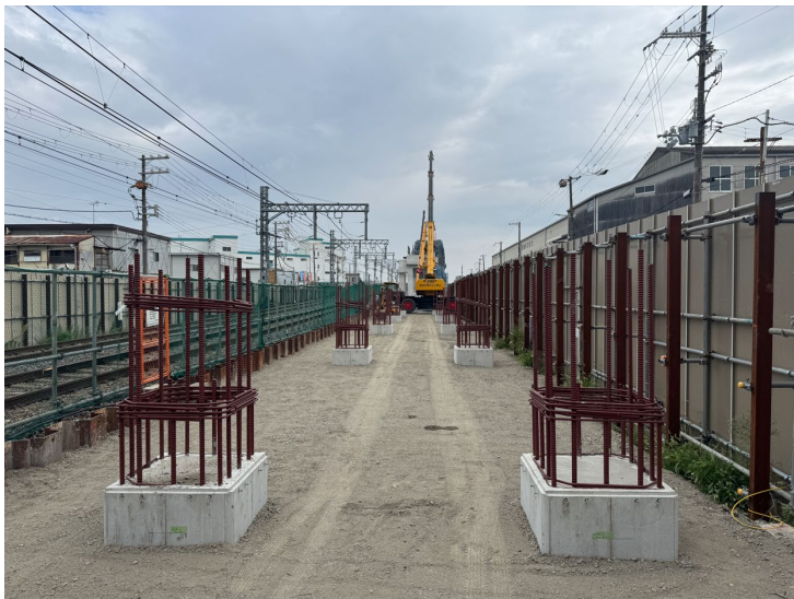
③躯体構築工（柱、埋戻し）
