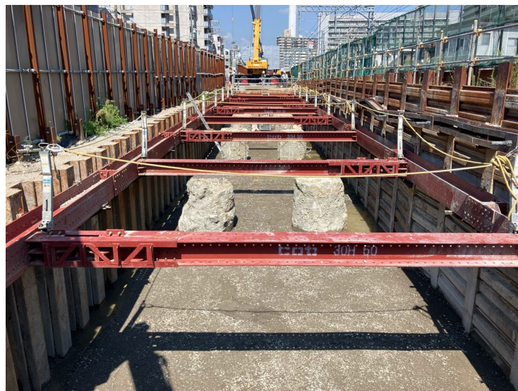
④躯体構築工（掘削、土留支保工）
