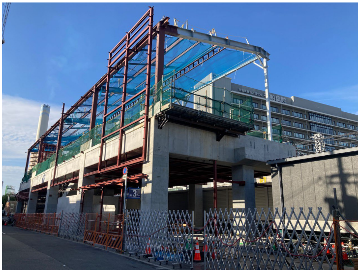
③躯体構築工（柱、埋戻し）
