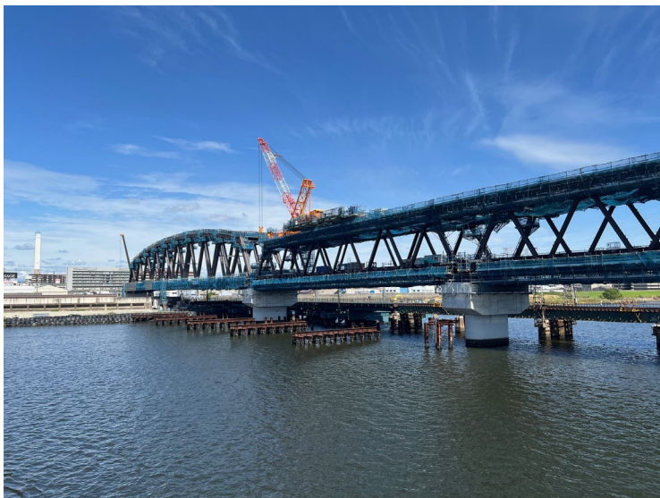
①上部工架設工
