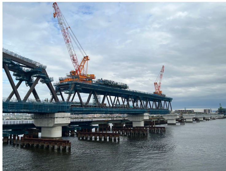
②上部工架設工
