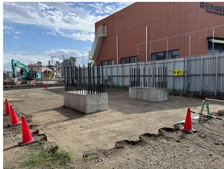
②躯体構築工（柱、埋戻し）
