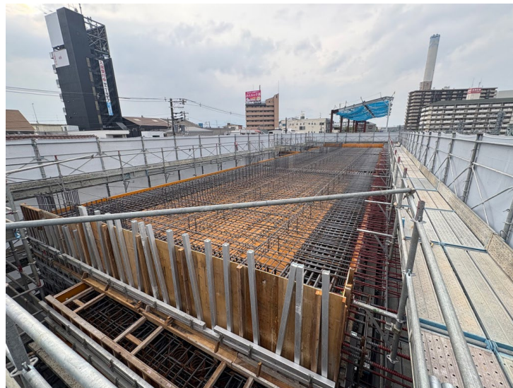
②躯体構築工（上床梁、スラブ）
