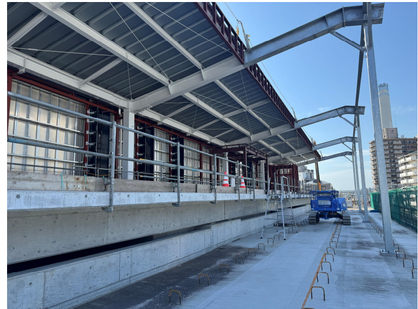
②計画駅舎構築工
