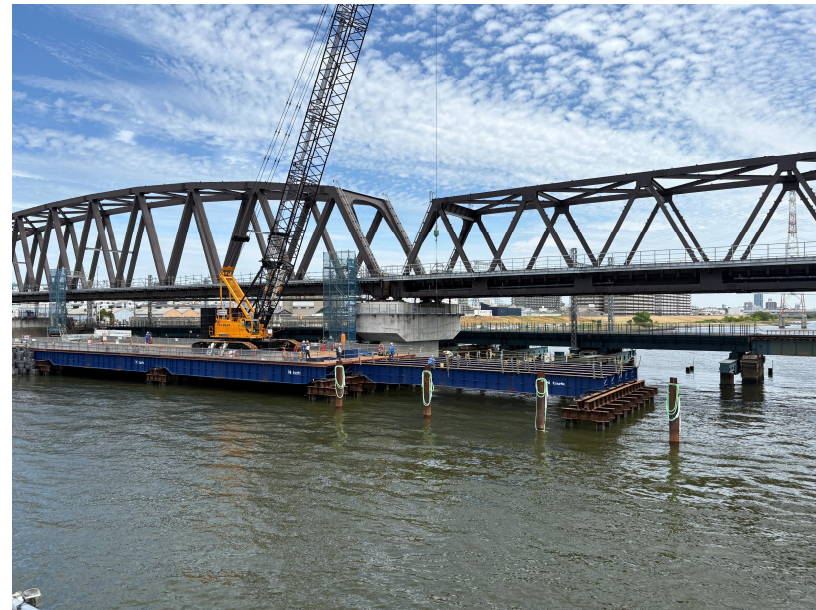
②栈橋撤去工
