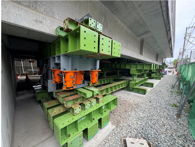
①PC桁扛上工
