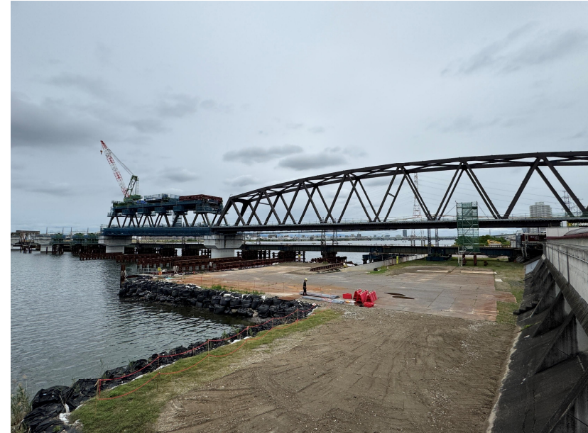
②上部工架設工
