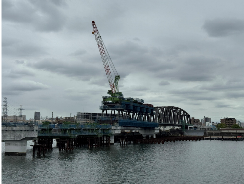
①上部工架設工
