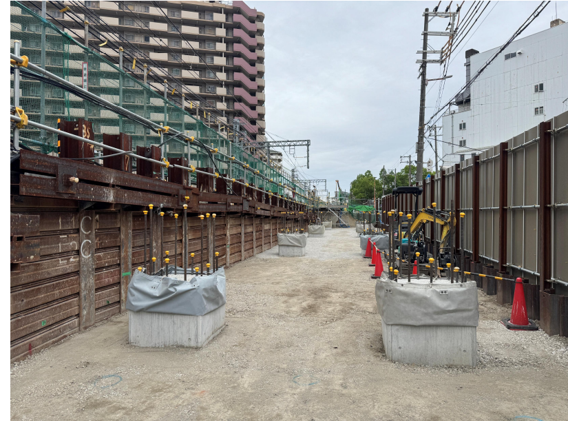
②躯体構築工（柱、埋戻し）
