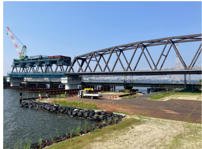
②上部工架設工
