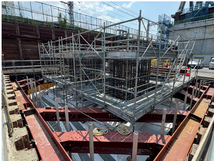
③躯体構築工（橋脚基礎、柱）
