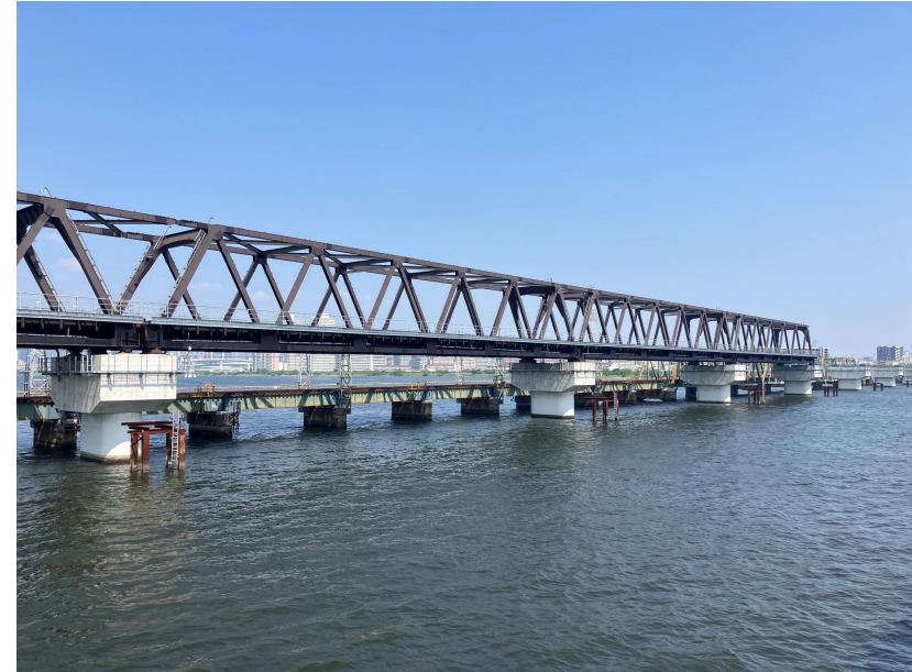
②上部工架設工
