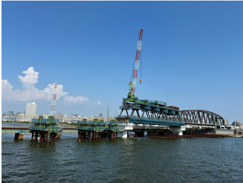
①上部工架設工
