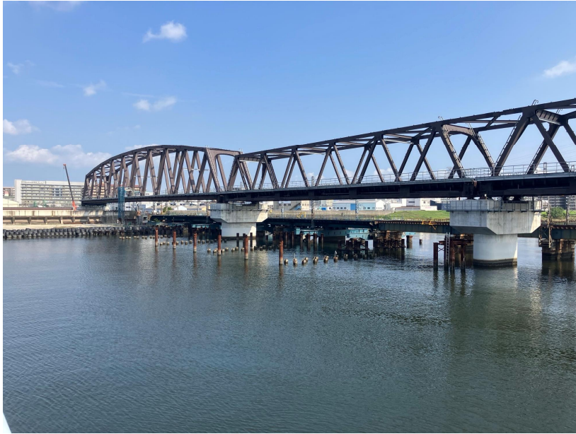
①上部工架設工
