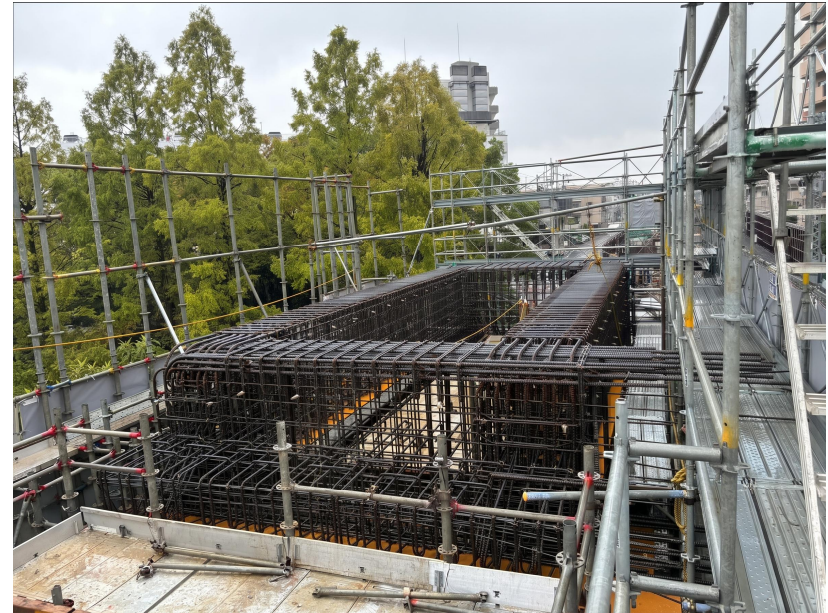
②躯体構築工（上床梁）
