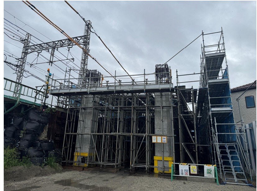
②躯体構築工（足場支保工）
