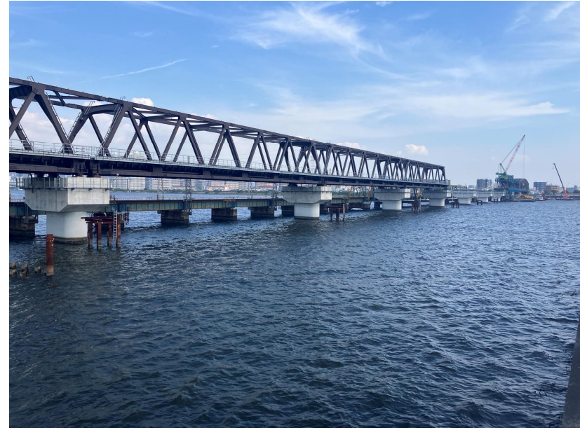
②上部工架設工
