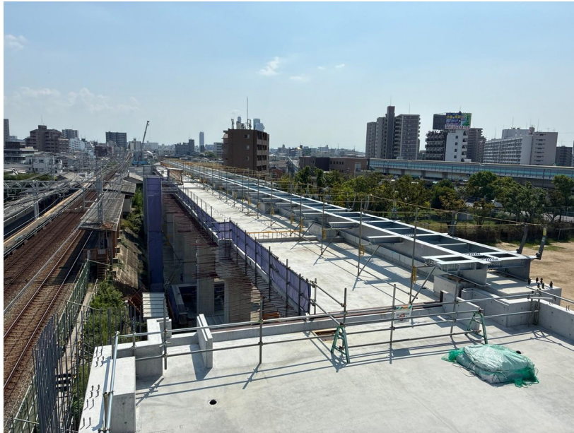
③躯体構築工（補強土壁工）
