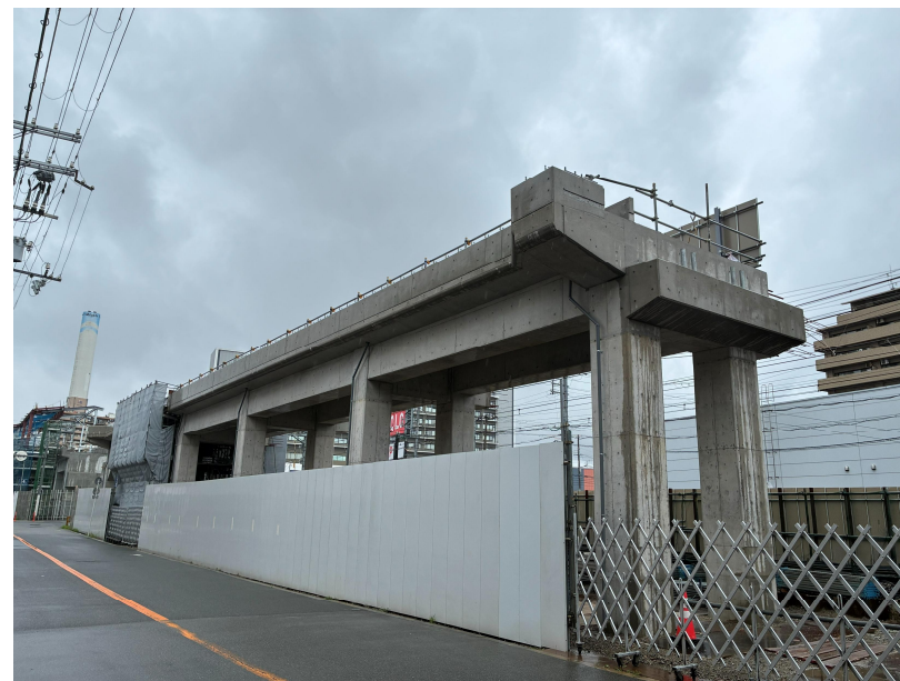
④躯体構築工（足場支保工）
