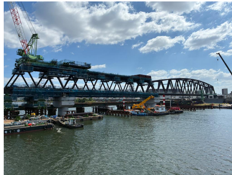
②上部工架設工
