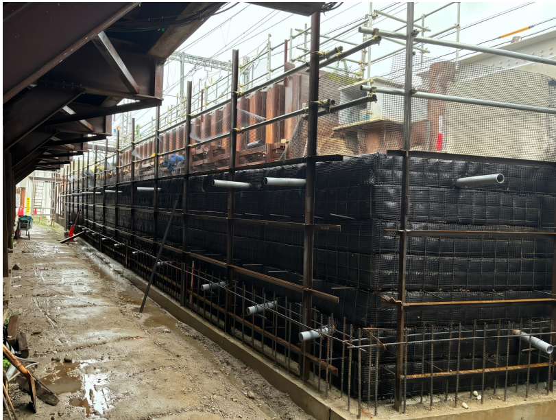
③躯体構築工（補強土壁工）
