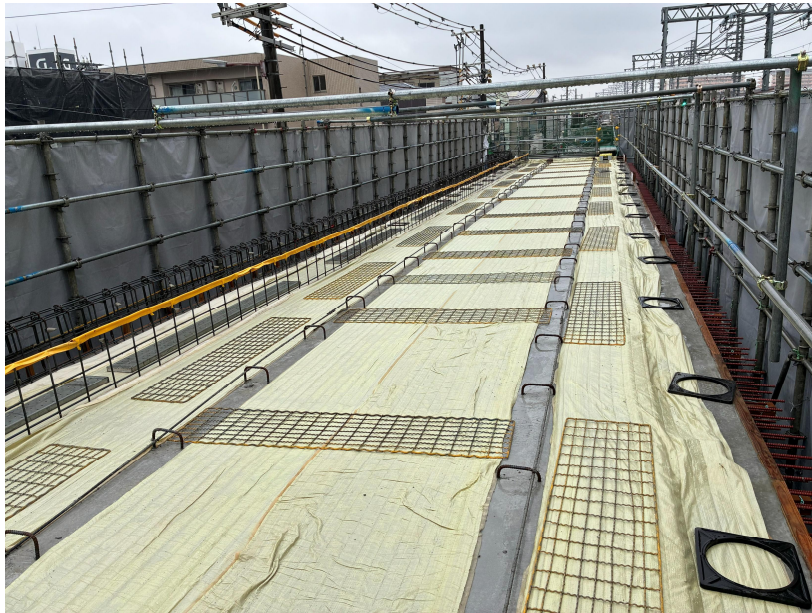
①躯体構築工（上床梁、スラブ）
