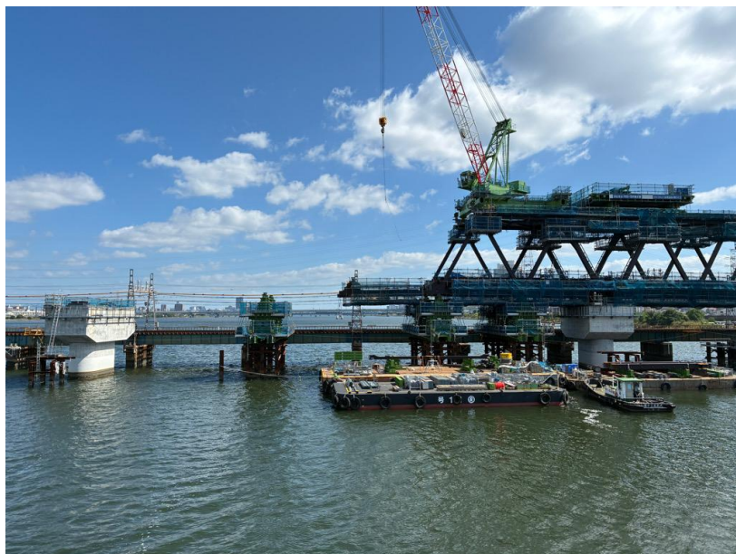
③上部工架設工
