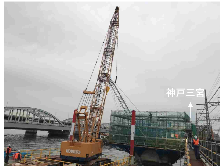
②梁構築工
