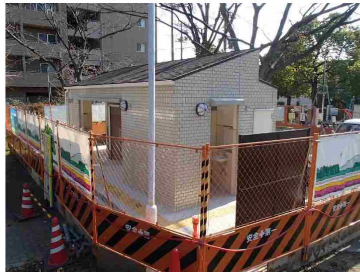
②工事ヤード整備工（トイレ移設）
