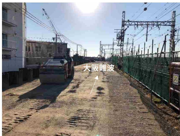
③仮線構築工（盛土工）
