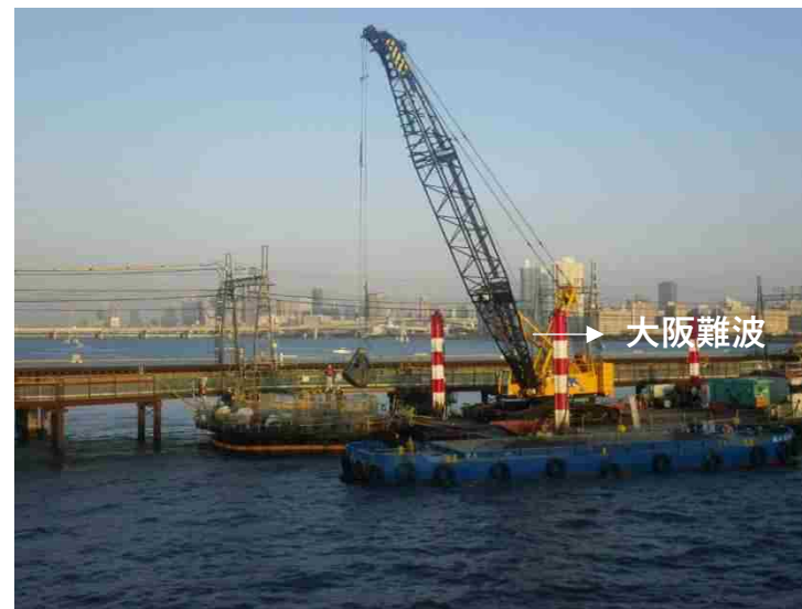
②鋼管矢板井筒基礎工
