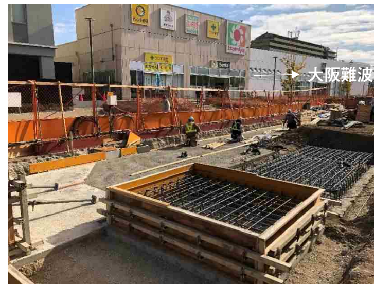
④仮駅舎工（基礎構築工）
