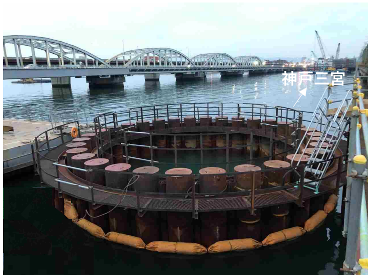
①鋼管矢板井筒基礎工
