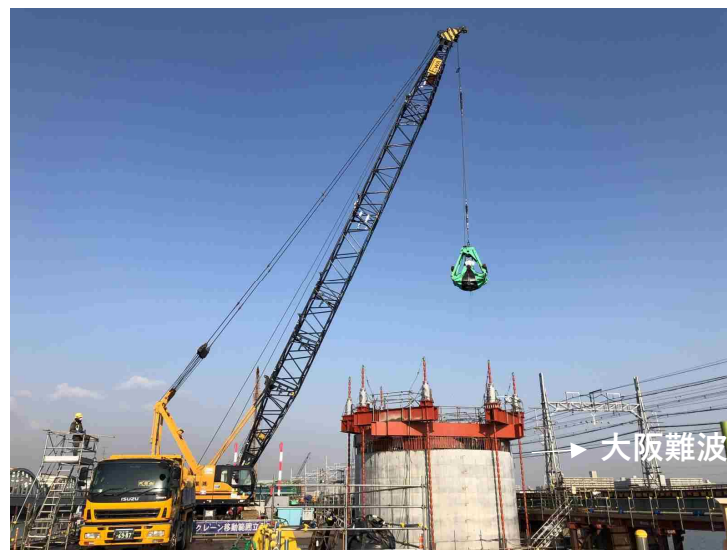
③オープンケーソン工
