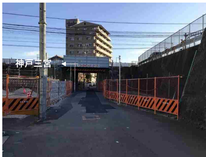
③支障埋設管移設工
