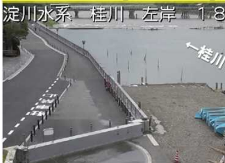
桂川河道掘削
