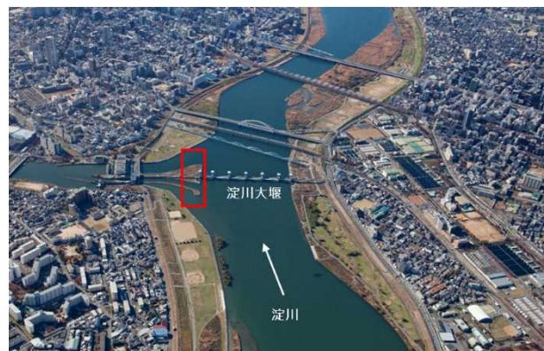
淀川大堰閘門設置位置 (平成26(2014)年11月)
