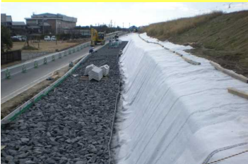
堤防強化(ドレーン工の施工例)
