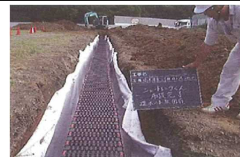
浸透トレンチ
