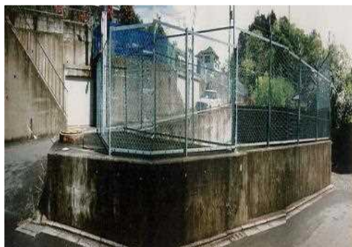
従前の防災調整池
