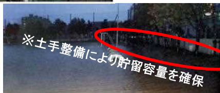
【校庭を活用した貯留施設】
