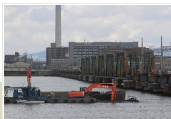
阪神なんば線淀川橋梁架け替え工事における舟運の活用
