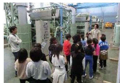
排水機場の見学
