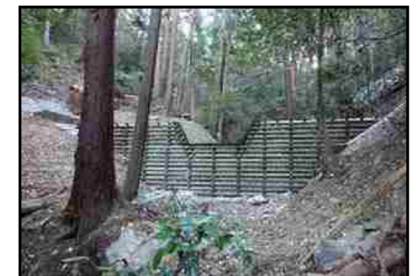
【治山：溪間工（治山ダム）】
