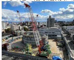
寝屋川北部地下河川 城北立坑築造工事
