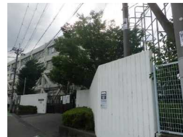
浸水深4.6m第四小学校正門
