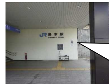
浸水深2.2mJR島本駅東口
