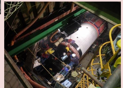
雨水管の施工状況
