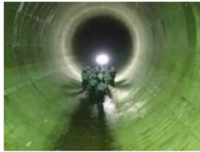
雨水貯留管の整備
