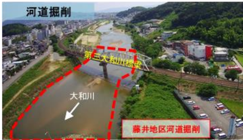
河道掘削(藤井地区)
