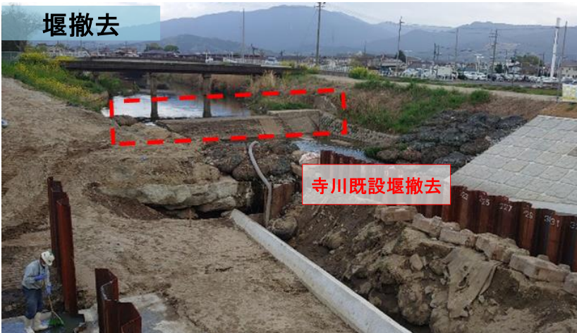
寺川堰撤去(桜井市大福工区)
