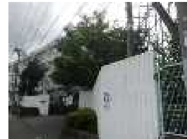
浸水深4.6m第四小学校正門
