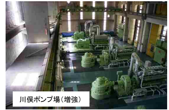
排水施設整備(ポンプ場)
