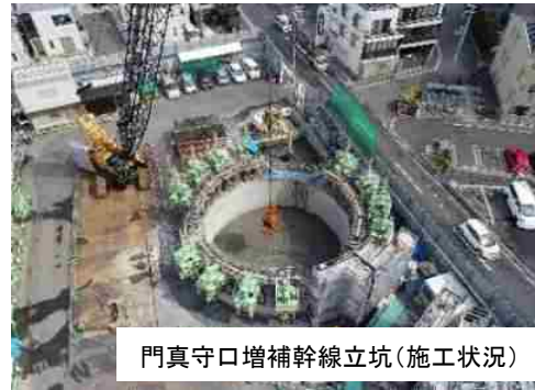
雨水幹線整備
