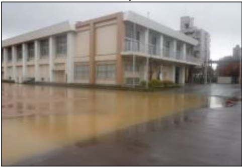
雨水流出抑制施設(市立小学校)
