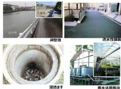
雨水貯留浸透施設の例
