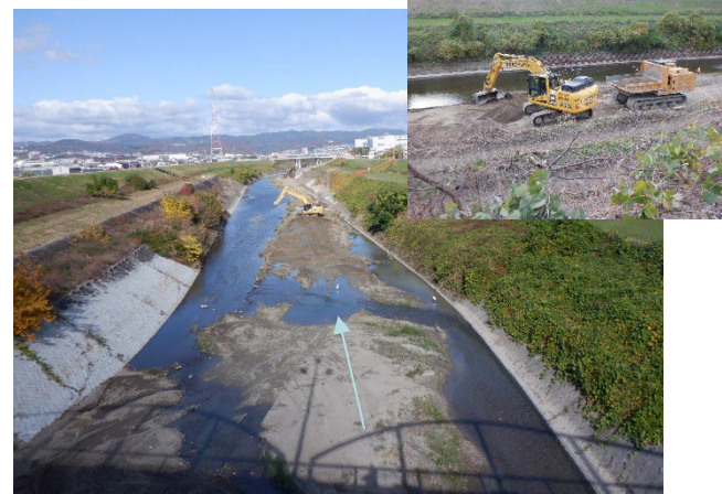
【芥川河川整備(国)の河道掘削状況】
