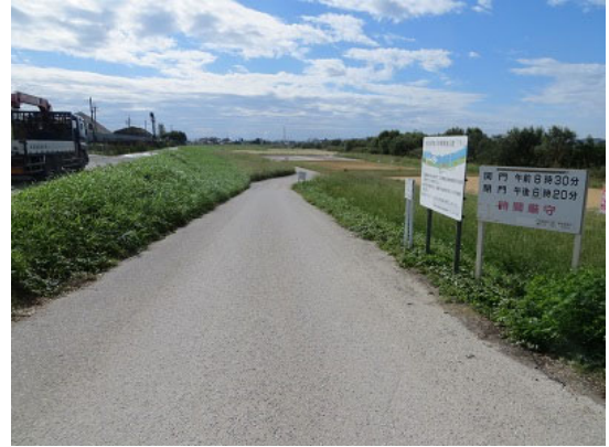
④公園への進入路（久我橋の下流側）
