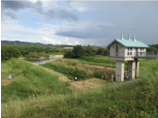
③ 占用施設を横切る樋門 v
