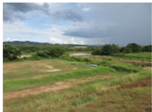
②上流側全景（上流側望む）
