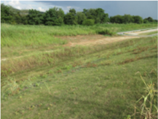
④ 下流側の占用地の通道
