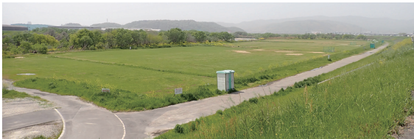
木津川河川敷運動広場（久御山町） 京都府木津川運動広場（京都府）（令和6年4月）
