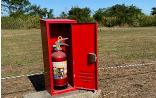
火災予防のため設置の消火栓
