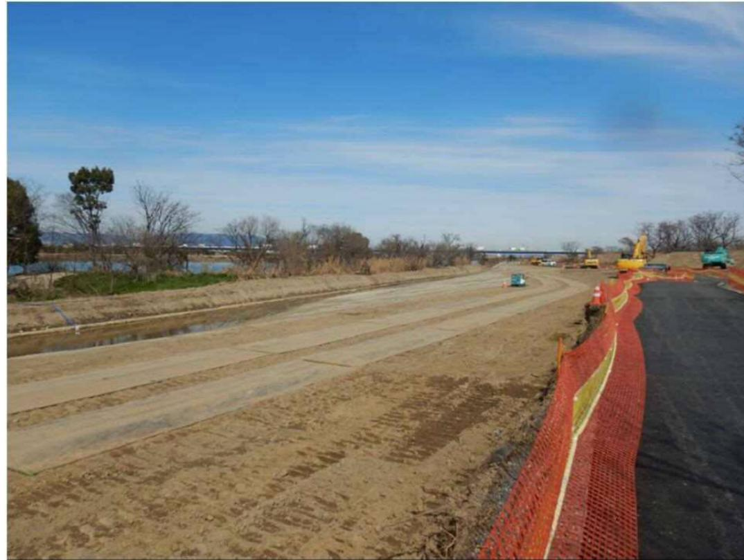
△仮設の管理用通路設置し、既存護岸撤去
