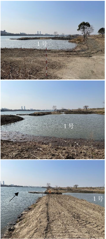
鳥飼1号ワンド（上流側から下流側を撮影）令和7年2月27日
