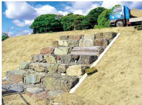
試験施工「穴太積」護岸
