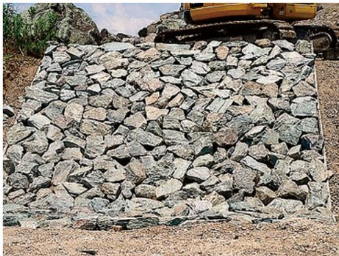
試験施工「背面アンカー付き自然石」護岸
