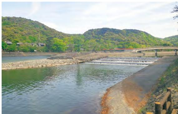
塔の川多段式越流堰
