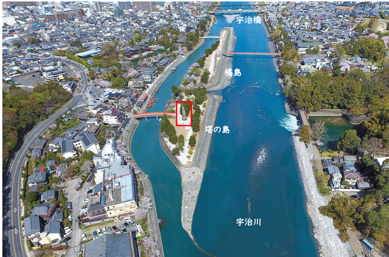
河川整備対象範囲の全景
