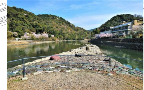
④石材による上流部導流堤
