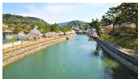
7 橋橋から上流を望む
