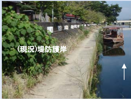
写真-2: 現況護岸(上流部)
