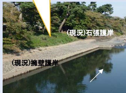
写真-1: 現況護岸(下流部)
