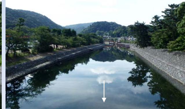
低水・高水護岸を一体整備
