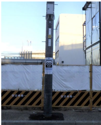
小倉駅周辺の電柱(宇治市)
