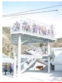
○避難タワーの設置
