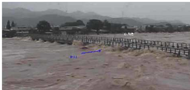
渡月橋の橋面を乗り越える洪水
