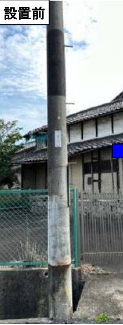
加茂小学校付近
