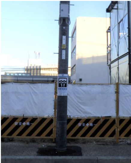
小倉駅周辺の電柱(宇治市)
