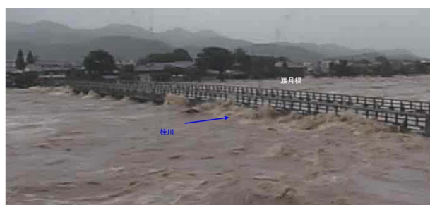
渡月橋の橋面を乗り越える洪水
