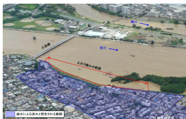
浸水範囲と土のう積みの範囲
