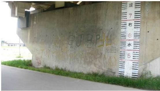
⑫ 新十三大橋橋脚上流すぐ 堤防の雑草除去作業中
