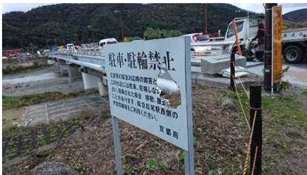
←松尾橋のすぐ横の看板が壊れていました。
