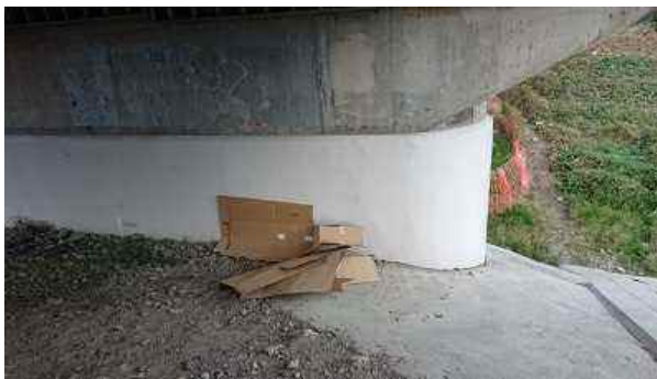
←松尾橋の橋下に段ボールの投棄物
