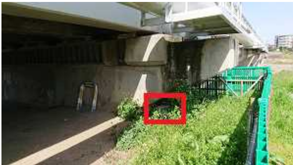
←松尾橋下に電子レンジの投棄
