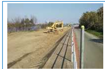
ワンド工事中に遭遇 3月完成後が楽しみ
