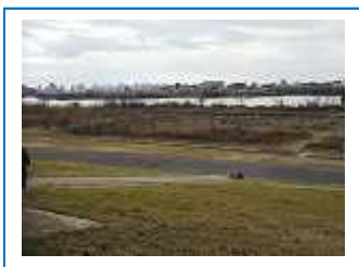
流水側の工事施工現場遠景
