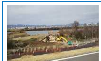
取水施設の工事現場 市水道局
