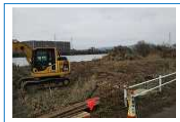
流水側すぐ側の整備現場（樹木伐採）
