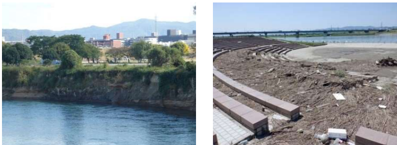
図 5.5 出水後の点検（河岸の崩落および流木等の堆積）
