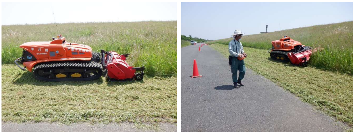
図 6.2 大型遠隔操縦式除草機による堤防除草の効率化
