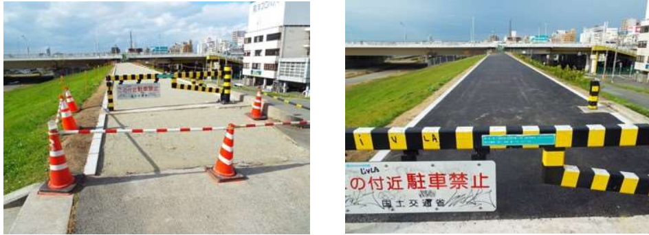
図 6.3 堤防天端の舗装
