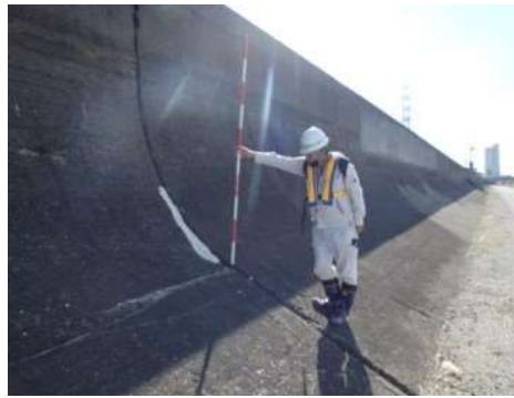
図 6.4 特殊堤の補修
