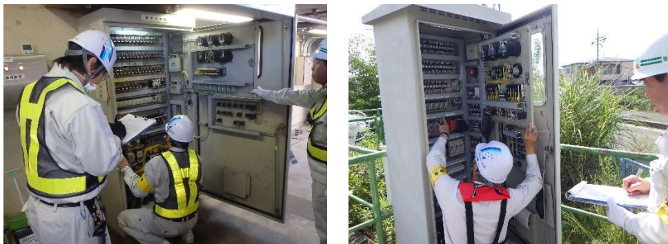
図 5.7 樋門機械設備等の点検
