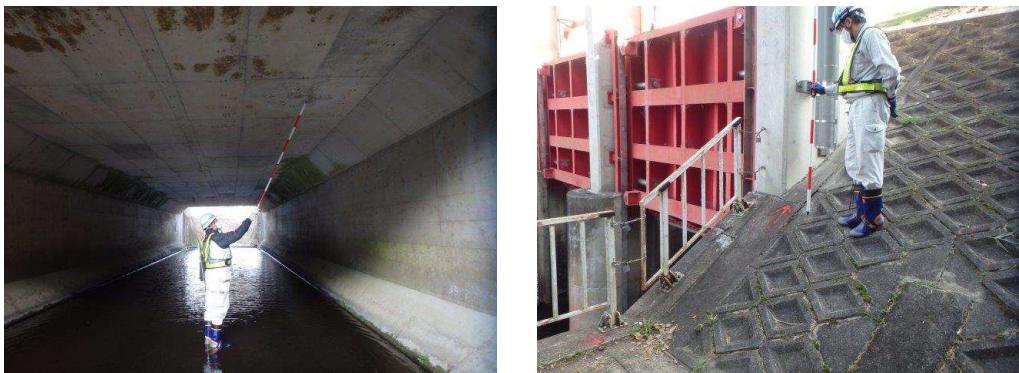
図 5.4 河川管理施設（樋門）の点検
