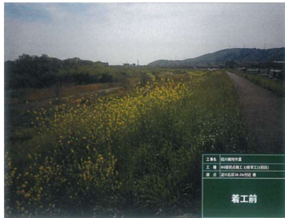
①除草前の状況
