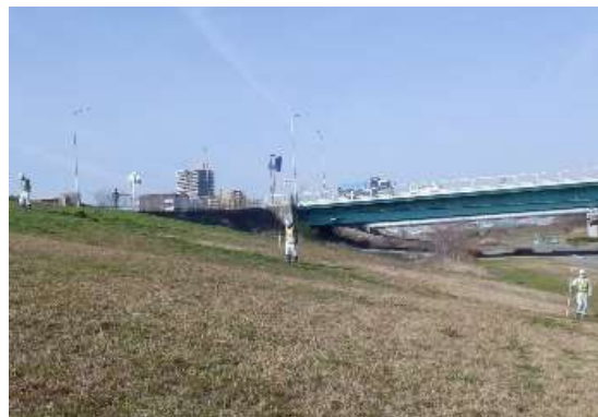
堤防点検の様子
