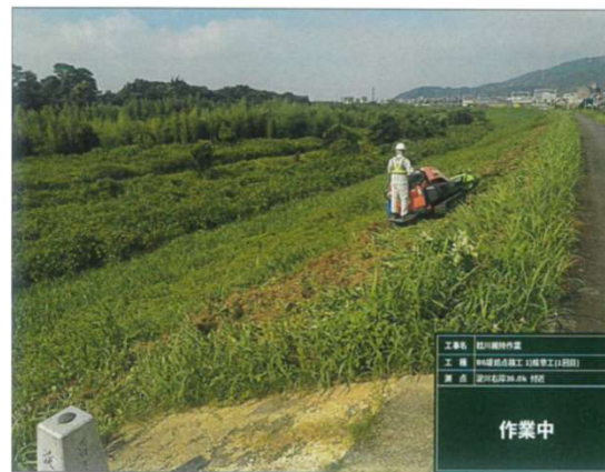
②除草作業中
