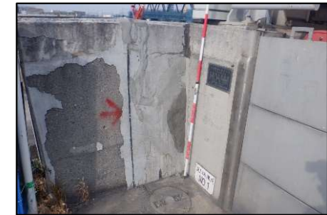
維持修繕工事
