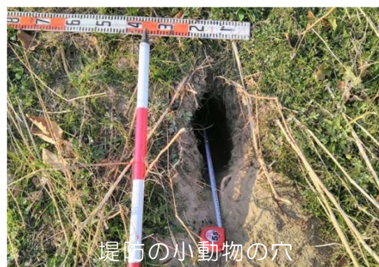
堤防点検により確認された異常
