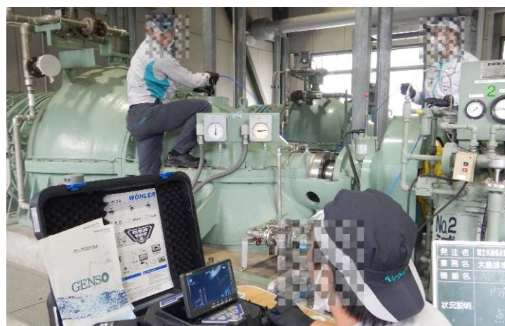
◀ 排水機場の 点検状況
