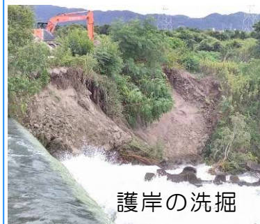
堤防や護岸等の変状の発見
