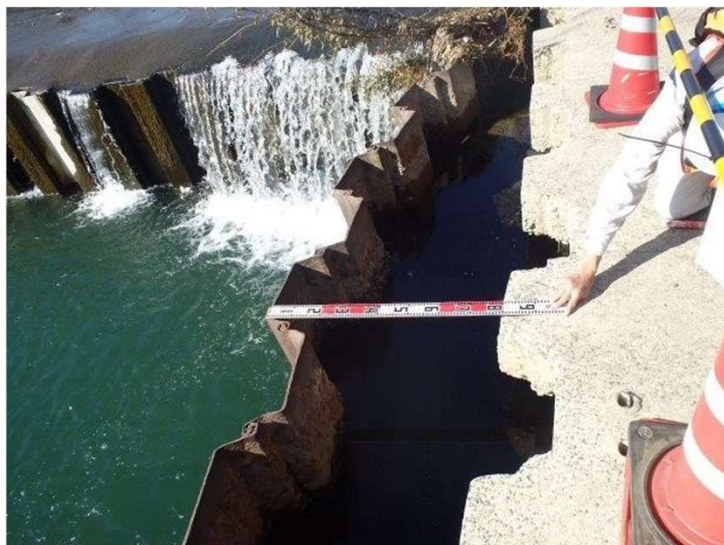
◀ 護岸の 点検状況 (矢板の傾斜)
