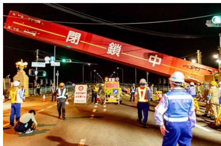
よどがわりっこう 淀川陸閘 閉鎖中 1時22分 （国道2号 淀川大橋左岸）
