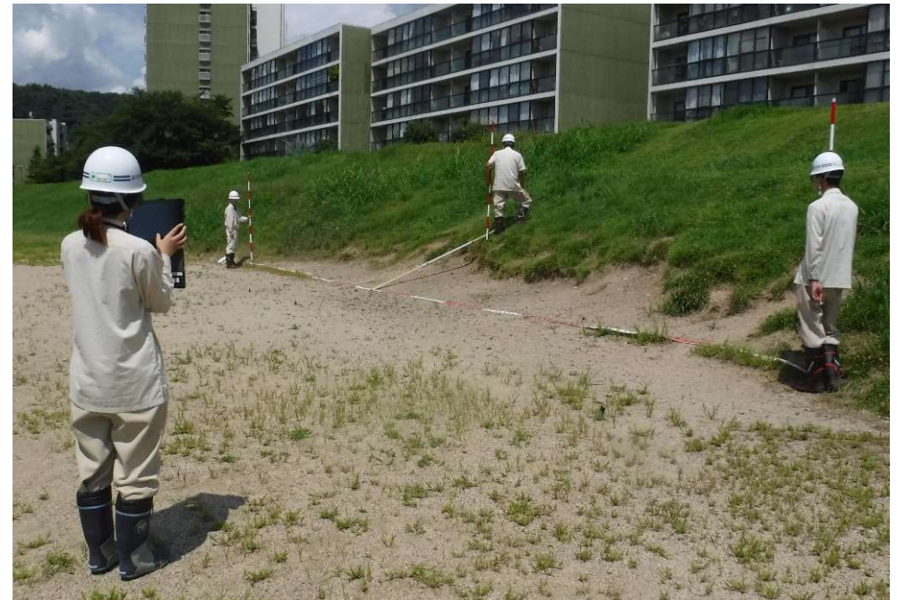
▲変状を発見し、実際に計測も実施
