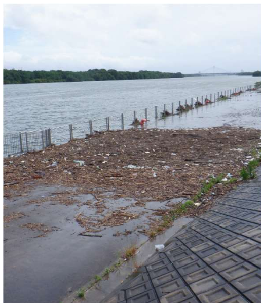
▲ 出水時河川巡視で確認 したごみ漂着 （令和6年5月出水時）
