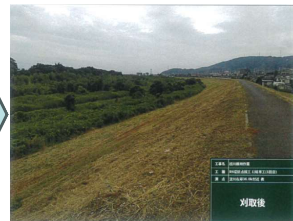
③除草作業完了
