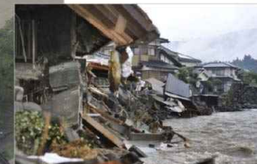
河岸侵食による家屋倒壊及び流出
