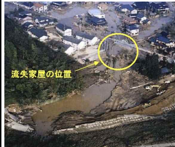
←堤防決壊に伴う氾濫流で木造家屋が倒壊した状況
