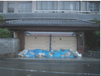
道路冠水に伴い自主的に防水板・土のうで防備
