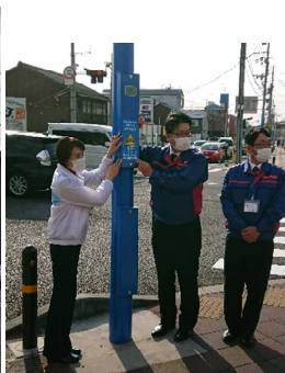
浸水表示板の設置（木津川交差点付近）
