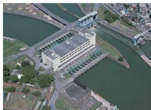
毛馬排水機場
