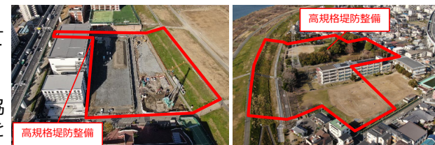
今年度実施箇所 (大阪市旭区大宮東地区) 今年度実施箇所 (守口市下島地区)
