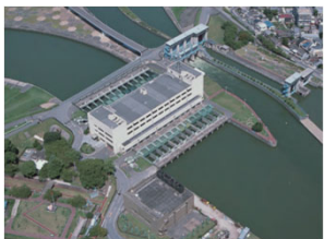
毛馬排水機場
