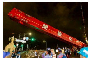
淀川陸閘の操作訓練
