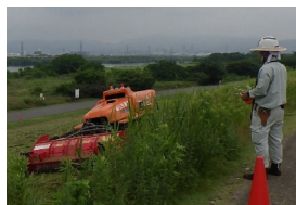
大型遠隔操縦式除草機による除草作業
