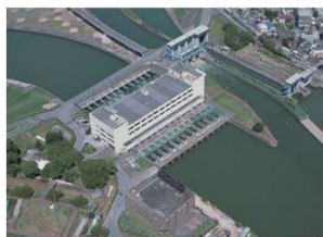
毛馬排水機場
