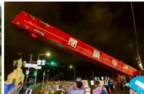
淀川陸閘の操作訓練
