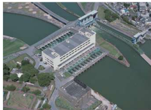
毛馬排水機場
