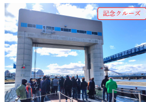
閘室内船上から見る淀川ゲートウェイ
