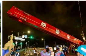
淀川陸閘の操作訓練
