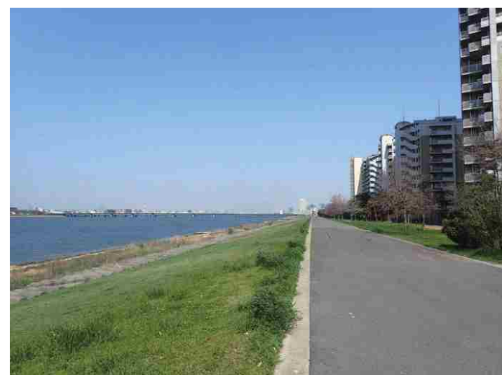
高規格堤防（西島地区）
