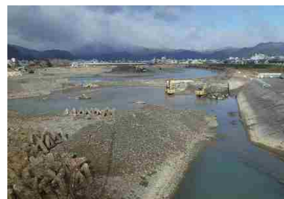
桂上野地区4号井堰撤去状況（平成31年1月）
