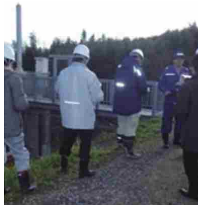
重要水防箇所の共同点検状況
