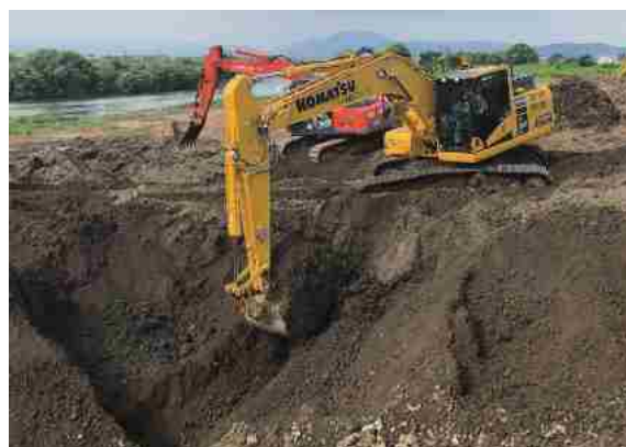
横大路地区河道掘削状況（令和元年9月）
