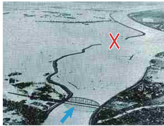
向島堤防の決壊(昭和28年9月 台風13号)
