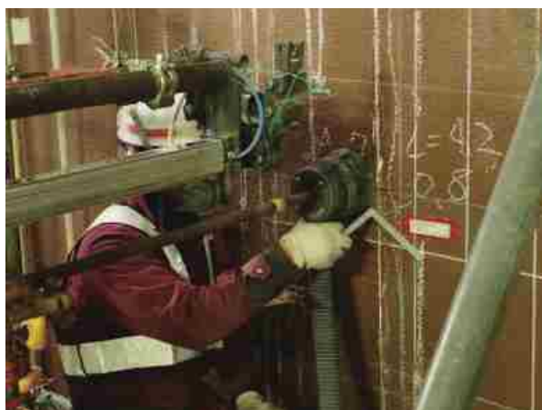
毛馬排水機場の耐震対策 鉄筋挿入工の施工状況
