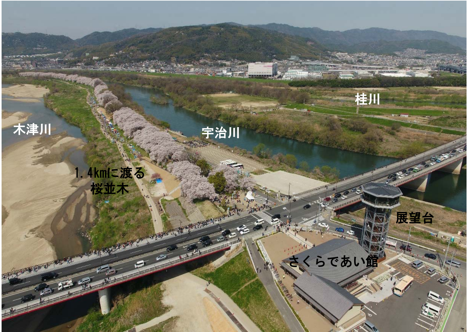
▲御幸橋上流側から下流方向を望む (H30. 4)
