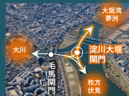
閘門設置後の淀川大堰周辺
