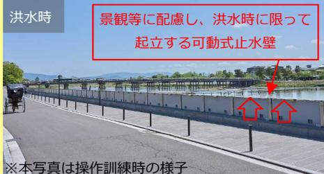
景観等に配慮し、洪水時に限って起立する可動式止水壁
